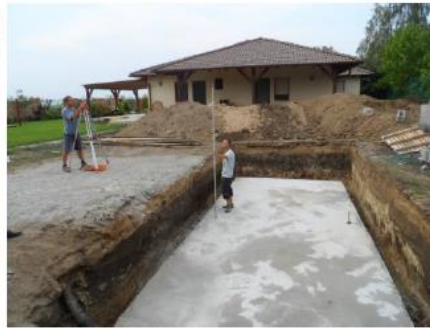
Nivellierung des Betonuntergrundes
